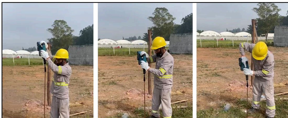
Figura 8 – Perfuração realizada com broca acionada por chave de impacto à bateria
