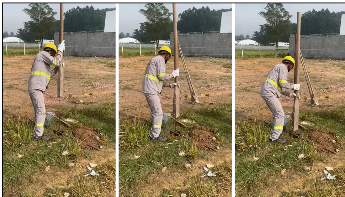
Figura 4 – Finalização da aplicação com uso do socador manual
