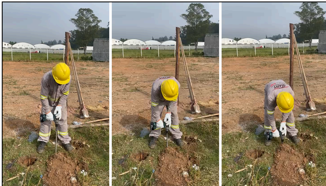
Figura 8 – Perfuração realizada com broca acionada por chave de impacto à bateria
